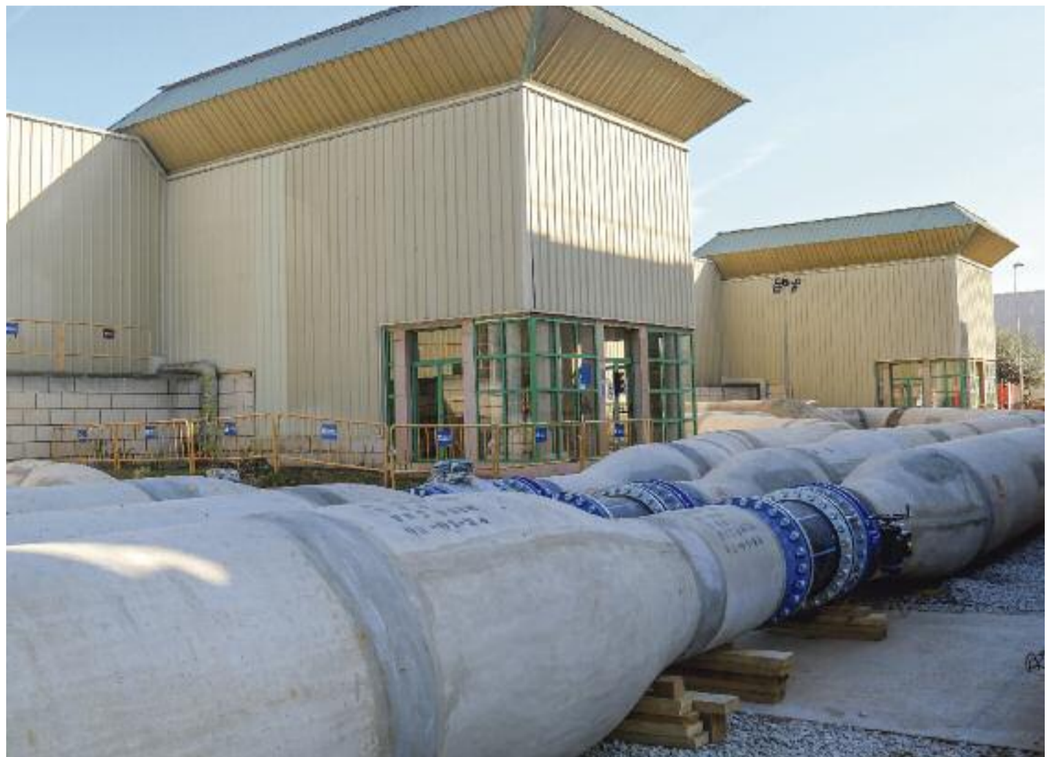
Les noves canonades que capten l'aigua subterrània a Sant Joan Despí. Foto: Àlex Recolons/ACN
